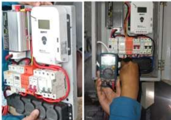
Gambar 5. Perakitan dan Pengujian Panel Kelistrikan
