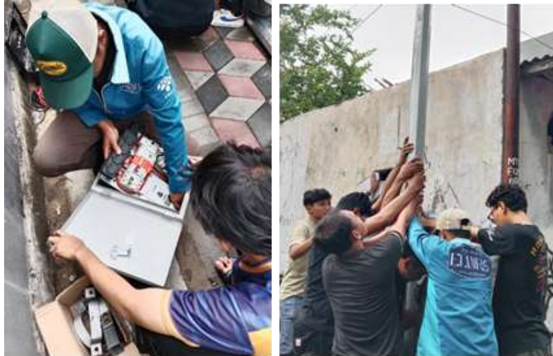
Gambar 6. (a) Proses Pemasangan Panel Kelistrikan dan Baterai (b) Proses Tiang PJU-Solar yang Dilakukan Oleh Mahasiswa dan Warga
